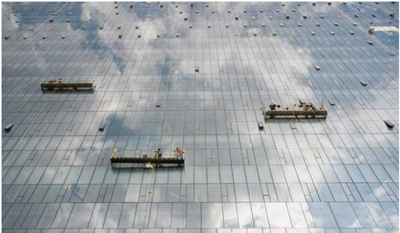
Construction du musée Soumaya dans la capitale mexicaine.
