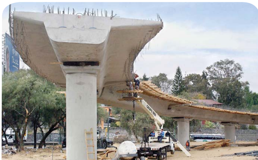
Le plan national de développement du Mexique comporte des propositions visant à stimuler les dépenses d'infrastructure au profit de projets tels que la construction de ce pont.
