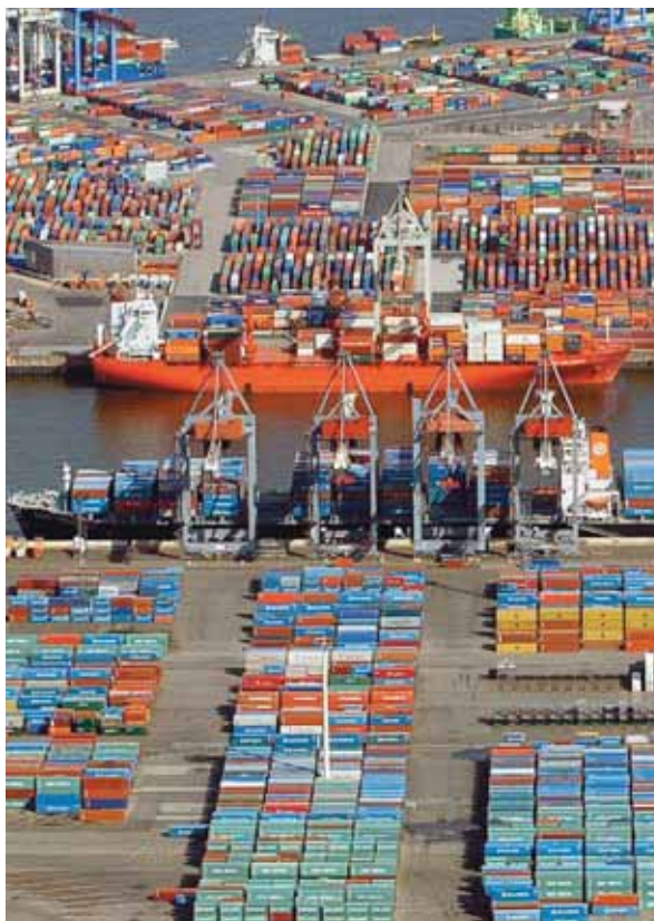
Muelle de contenedores, Hamburgo, Alemania.
