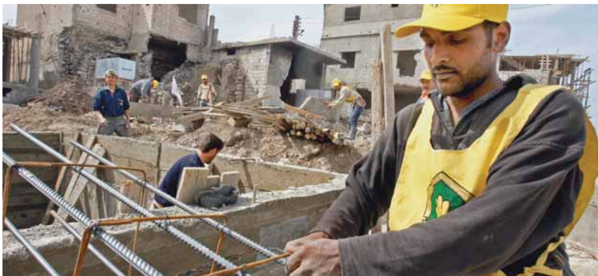
Tareas de reconstrucción tras el conflicto en Líbano.
