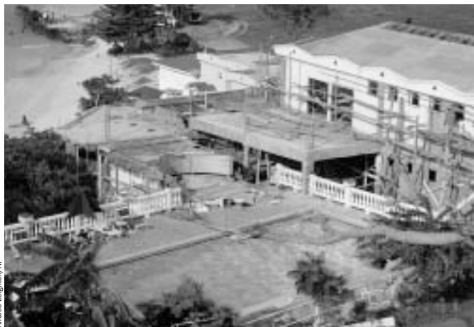
Reconstruction d'un hôtel à Saint-Georges (Grenade) après le passage de l'ouragan Ivan. Les catastrophes naturelles sont courantes dans la région.
